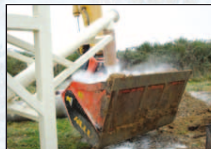
Stabilisation par traitement à la chaux
