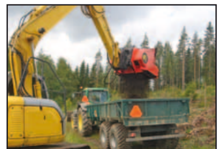
Criblage et chargement simultanés
