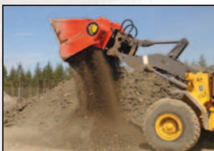
Aération de sols et inertage
