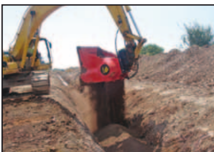
Criblage/Remblaiement de tranchée
