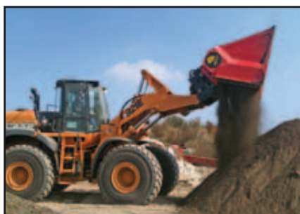
Criblage de terre
