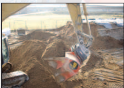
Stabilisation pour fondations
