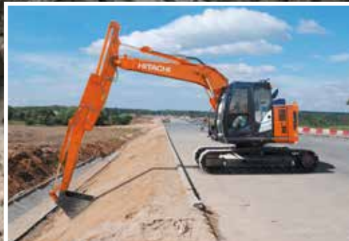
L'utilisation combinée de la flèche et du bras permet une finition douce des pentes.
