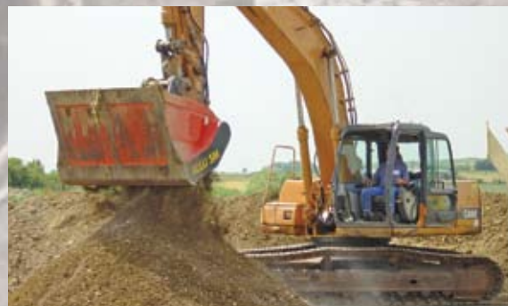
7. Criblage de terre végétale
