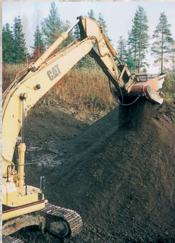
10. Stabilisation de l'argile et du sol contaminé
