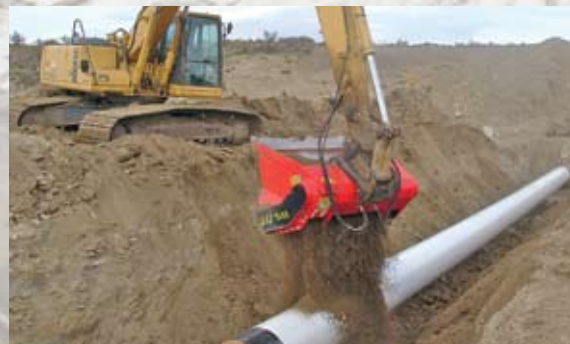
6. Remblaiement direct de tranchées
