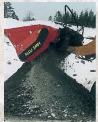
13. Broyage du béton léger
