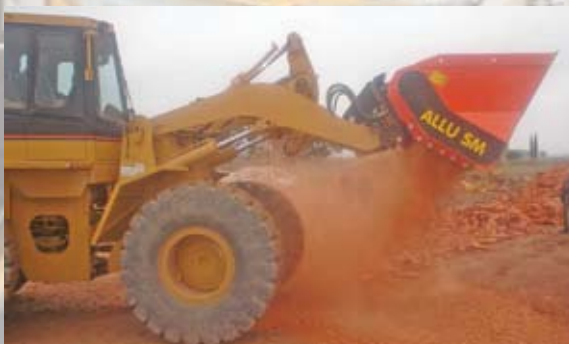
3. Broyage de briques
